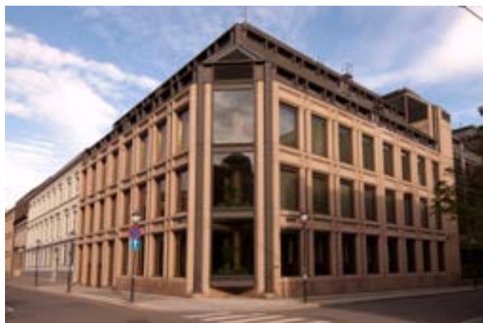
Norges Bank er bygget av drammensgranitt fra Røyken
