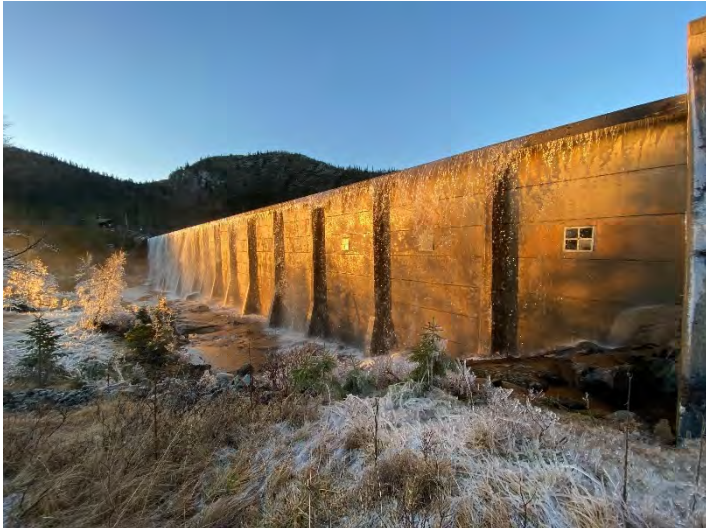
Betongplatedammen ved Skjesvatn blei bygd i åra 1957-1959. Foto: Skagerak Energi.
