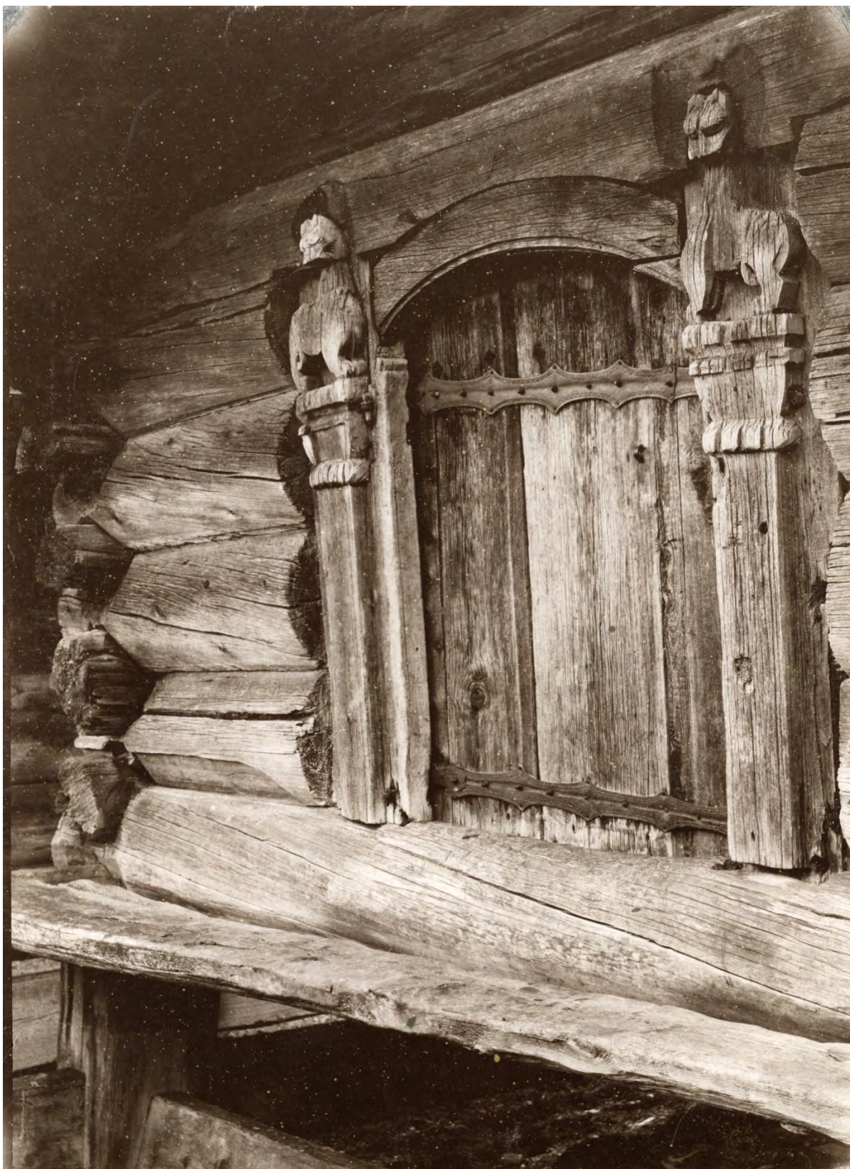
Fronten på vesleburet på Sud-Åbø, med kapiteldyr på beitskia. På folkemunne er det sagt at buret har ei tilknytning til stavkyrkja som blei riven i 1809. Byggmeistaren for begge skal vera ein Pål frå Åbø, og buret skal ein gong ha vore nytta som likhus. Dette er ikkje verifisert, heller ikkje alderen på bygningen. Arne Berg daterte det ut frå innslag av Findalslaft til før 1350. Seinare har fagfolk funne ut at denne teknikken var i bruk noko lenger fram i tid. Foto: Johan J. Meyer 1910 (Riksantikvaren).
