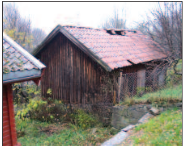
Uthus Lienveien 48 og 50.
