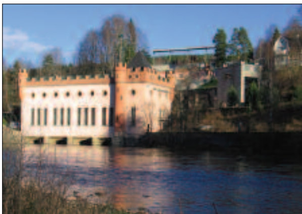
Kraftstasjonen med ventilhus og transformatorbygg 2005
