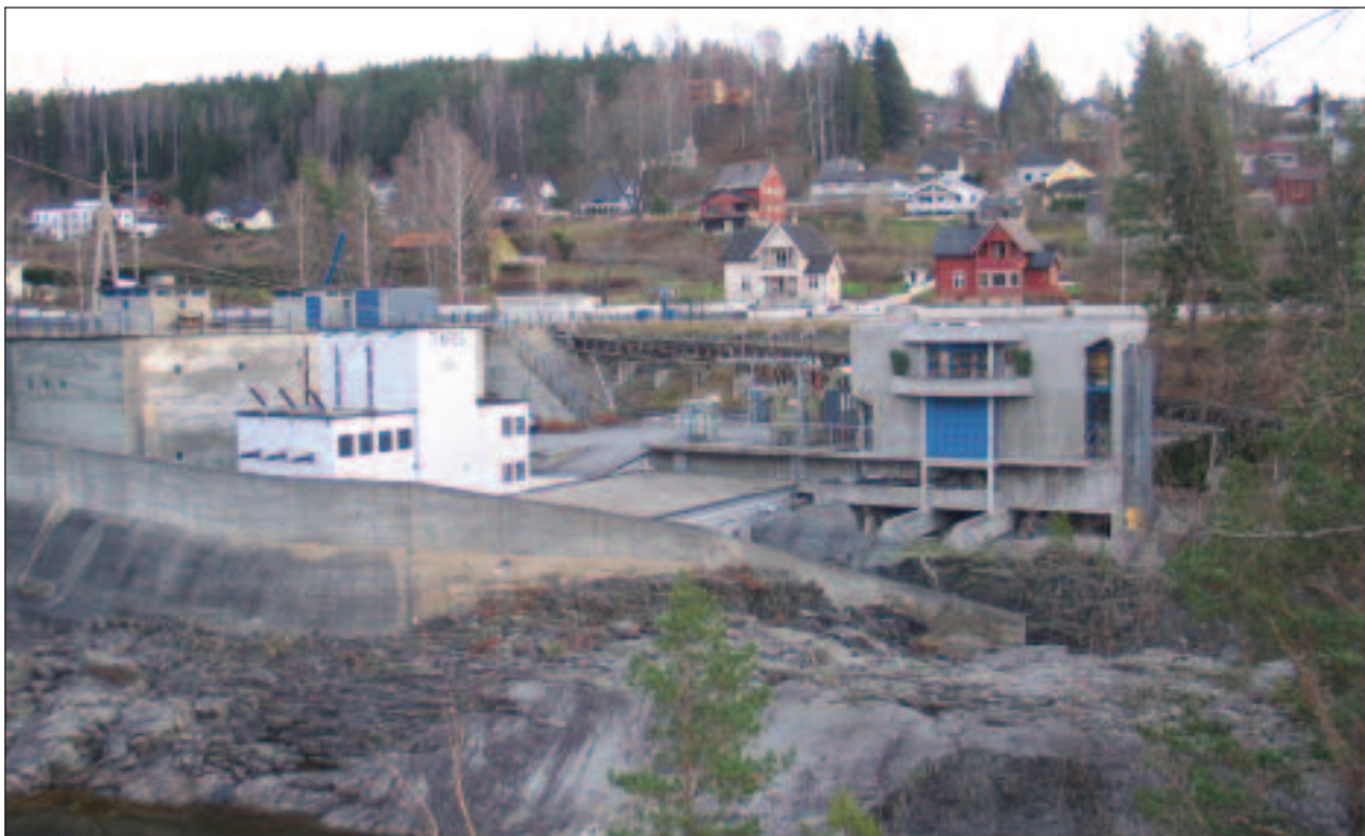
Nye Tinfos 1 med kontrollsentral og Kanalveien bak
