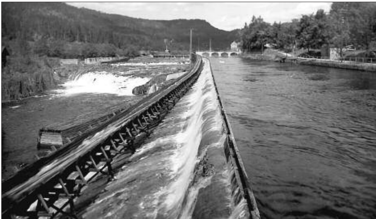
Holtakanal stod ferdig i 1912. Til venstre Sagavossen før oppdemming
