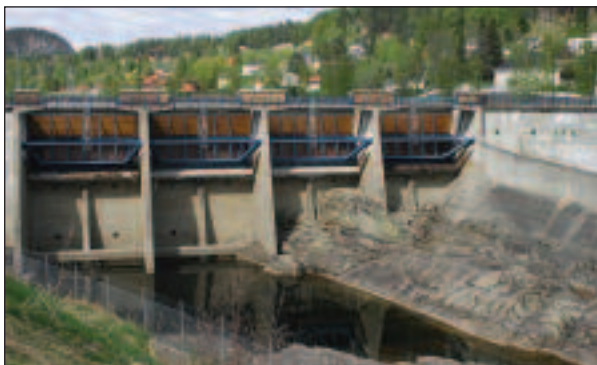
Betongplatedam ved nye Tinfos 1 2005
