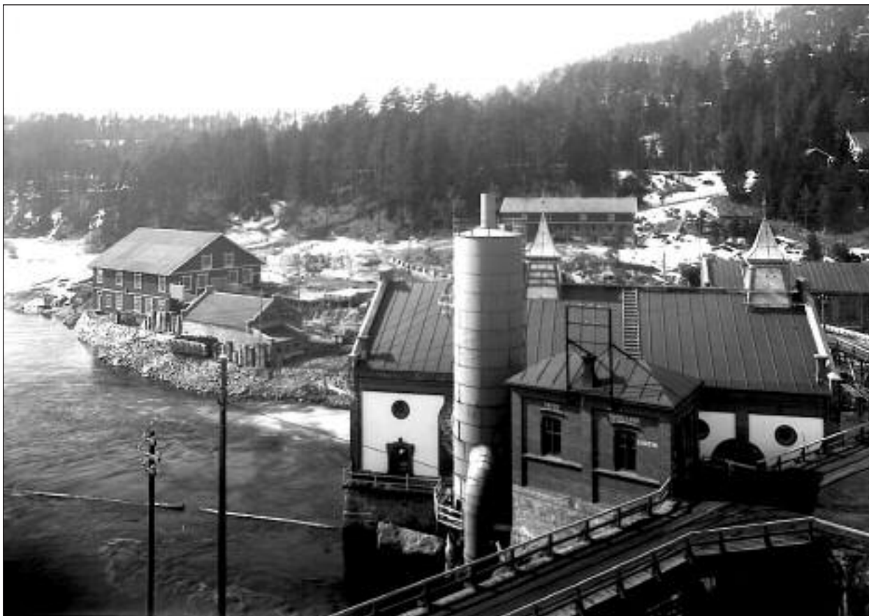
Første kraftstasjonen Tinfos 1 ca 1920
