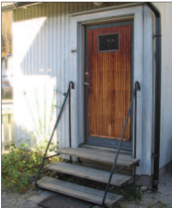
Tinnesgata 51, utanpåhengt trapp typisk for arbeidarbustadar med fleire bueningar.
