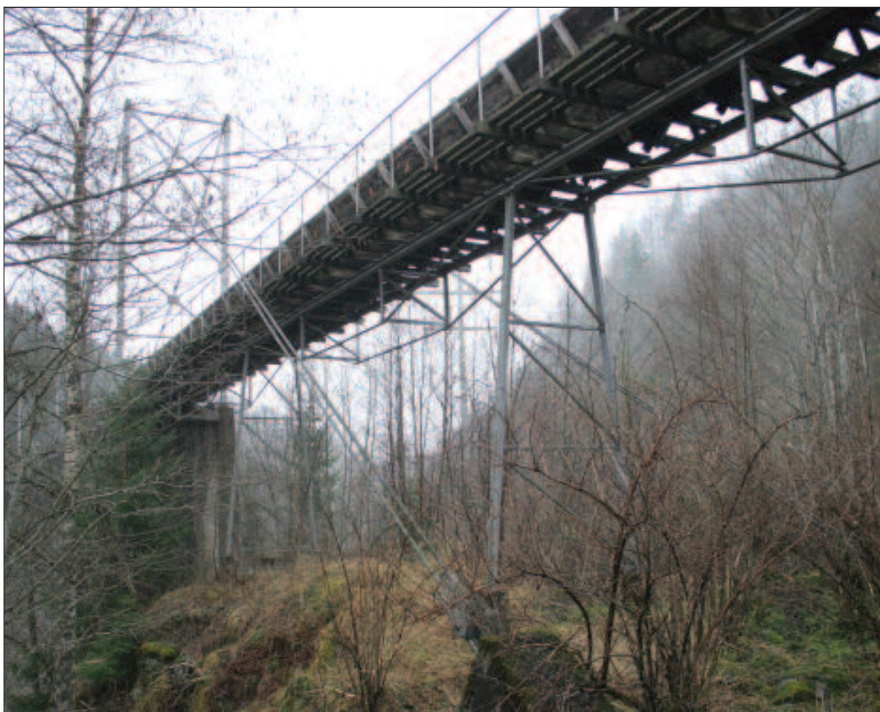
Vernesone A6 er tømmerrenna med konstruksjon og fundament. Vernesone C4 er grunnen tømmerrenna står på
