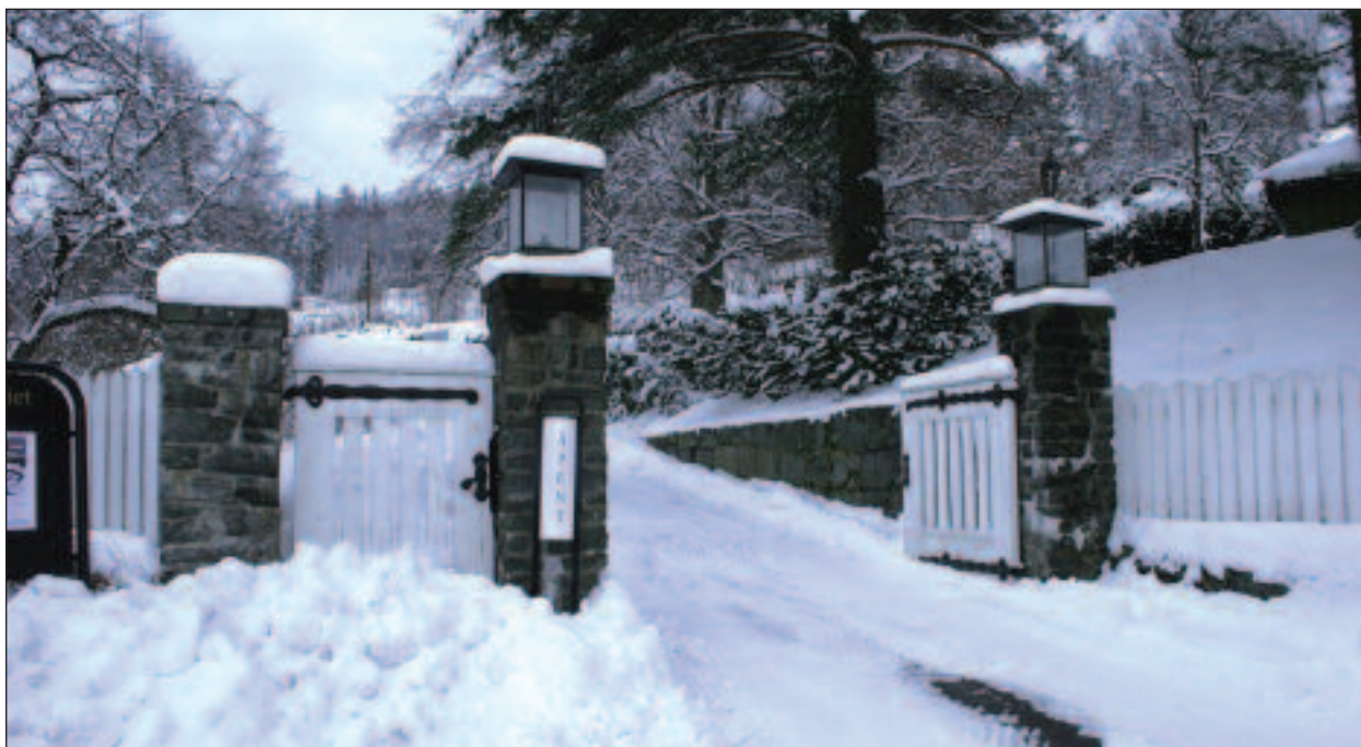
Original inngangport Kanalveien 29
