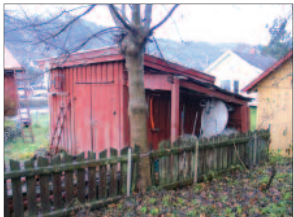
Uthus til Kanalveien 55.
