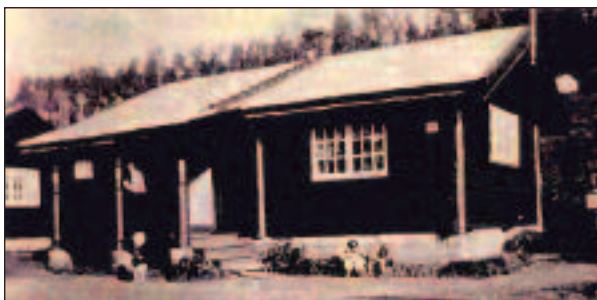
Kanalveien 61 eller 63, sleppverk
