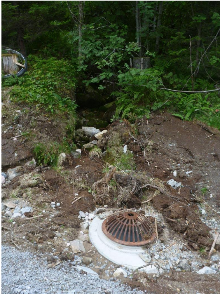
Bilde av kum over kulvert i Sideløp 1 (ref. Figur 5).
