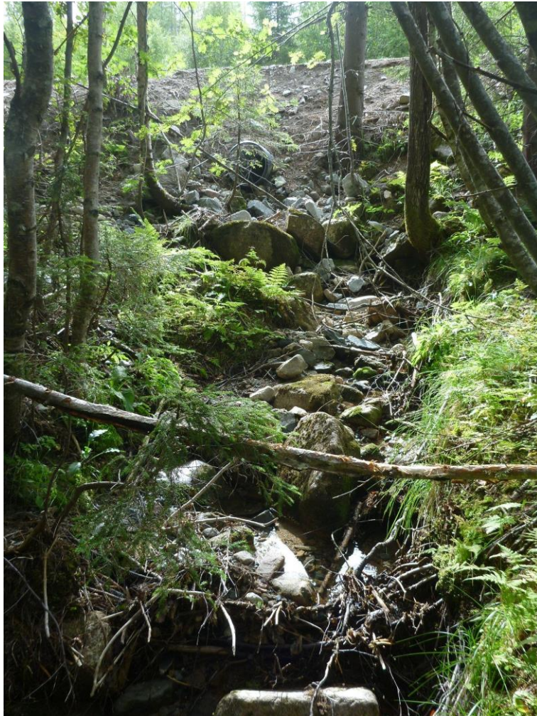
Bilde av kulvert i Sideløp 1 (ref. Figur 5).
