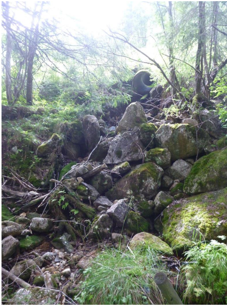
Bilde av kulvert i Sideløp 2 (ref. Figur 5).
