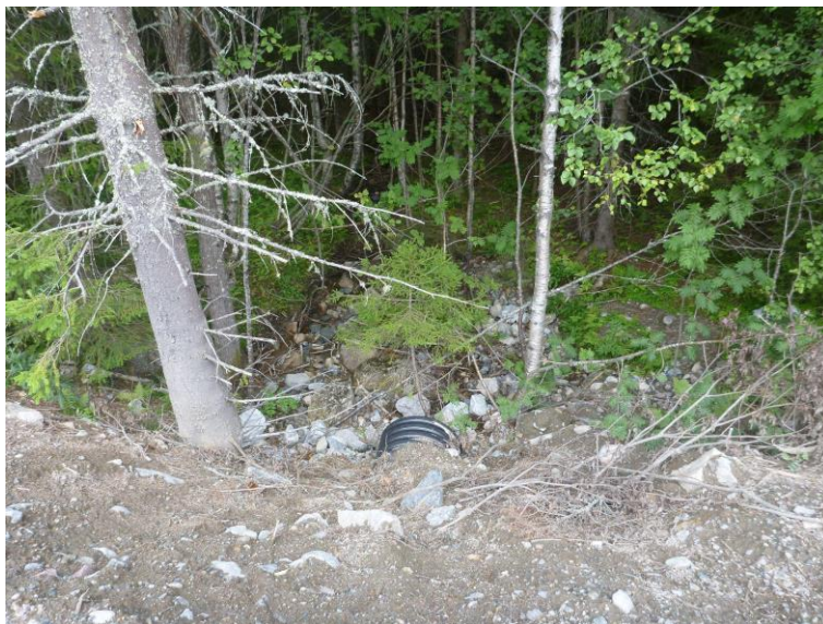
Bilde av kulvert i Sideløp 1 (ref. Figur 5).
