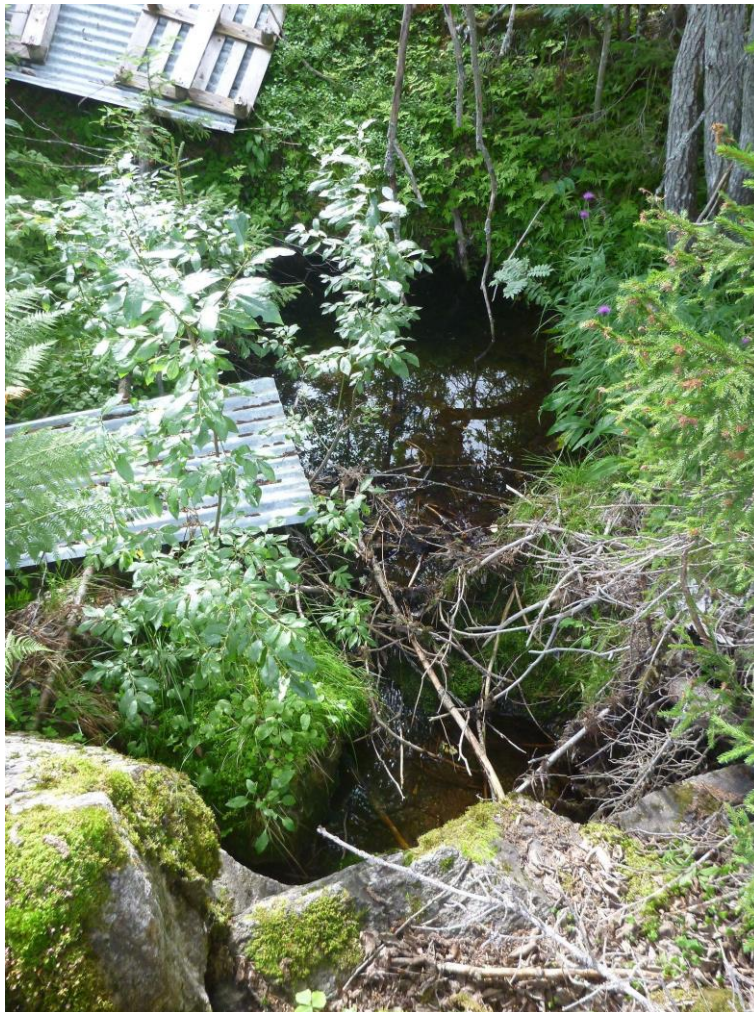
Bilde av over kulvert i Sideløp 2 (ref. Figur 5).
