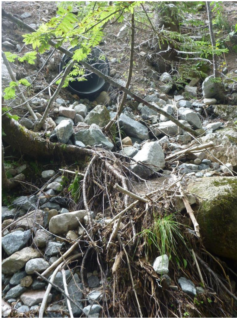
Bilde av kulvert i Sideløp 1 (ref. Figur 5).
